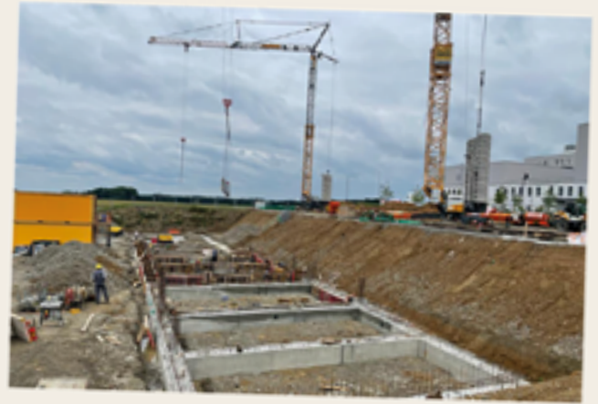
Juni 2022: Der Rohbau der neuen Rettungswache nimmt langsam Gestalt an.
