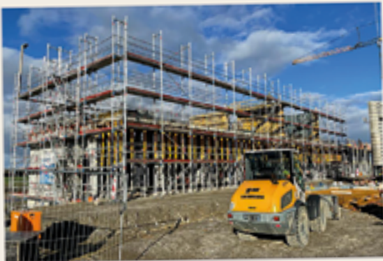
November 2022: Die Arbeiten für das erste Obergeschoss beginnen. Dort sind später unter anderem Büros, Schulungsräume, Sozialräume und Umkleiden untergebracht.
